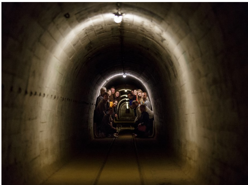
Spurensuche auf 23 Metern „Tiefe“. Foto: Ondřej Cinkajzl | oc-photo.com
