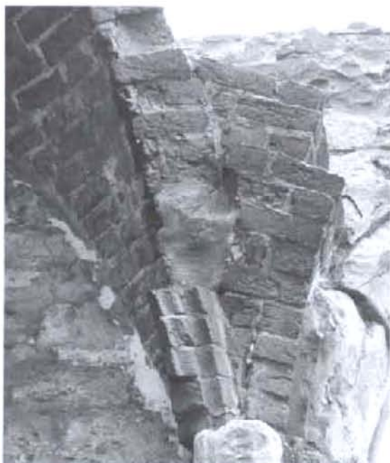
Abb. 15 Der obere Bereich des nördlichen Dienstbündels mit den von ihm ausgehenden Rippenansätzen aus Backstein (Foto Verfasser).
