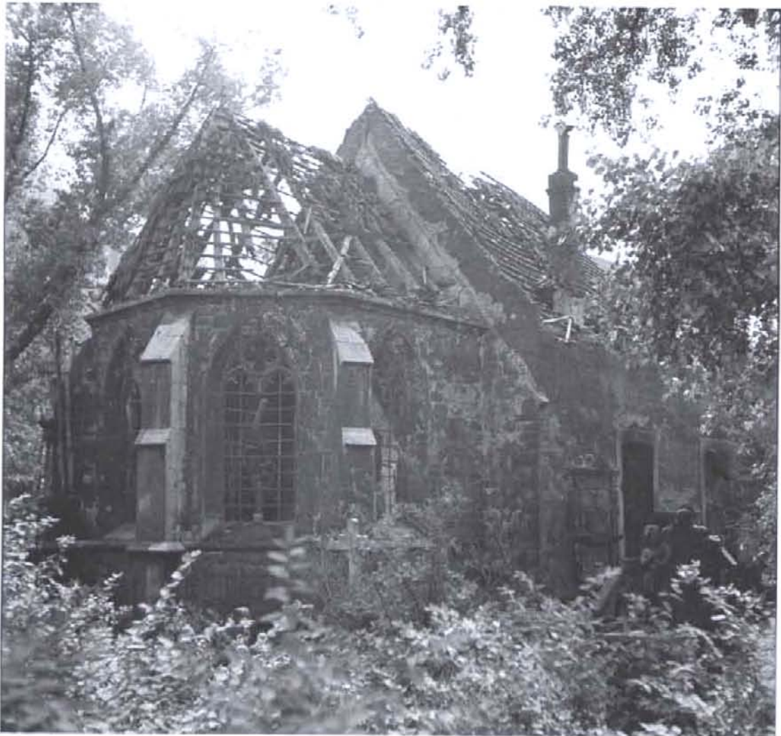
Abb. 20 Die Nikolaikapelle im Jahr 1944. Auch nach dem Bombardement waren große Teile der Maßwerkfenster und der Dachkonstruktion erhalten. Foto: Niedersächsisches Landesarchiv Hannover.
