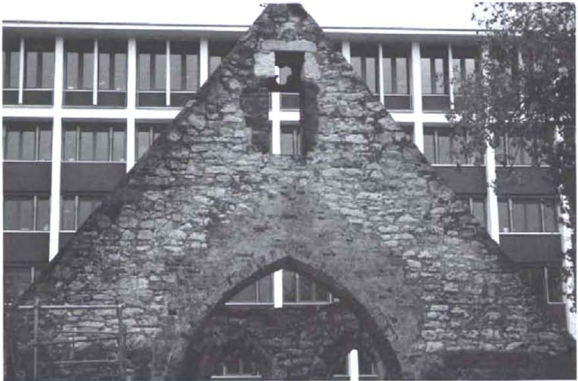
Abb. 7 Giebelwand zwischen dem abgerissenen Kapellenschiff und dem Chor, Westansicht (Foto Verfasser).
