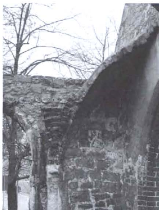
Abb. 16 Die beiden an die Giebelwand anschließenden Eckschalen des Chorgewölbes (hier die südliche zu sehen) wurden besonders steil geführt, so dass sie weit über die Mauerkrone aufsteigen (vgl. Abb. 10). Ohne die Präsenz der Giebelwand wäre das nicht so einfach gewesen.
