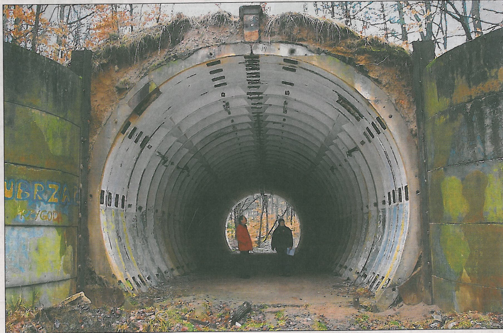
Röhre aus Beton und Stahl: In diesem Silo befand sich einst eine mobile Abschussvorrichtung für Atomraketen.
