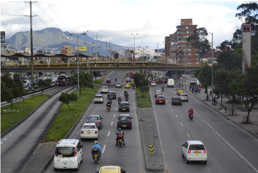
Transmilenio-Station der UNAL
